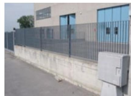
Expresamente bajo petición, podemos fabricar los postes correspondientes para la colocación de los paneles, realizados en pletina, para empotrar o con placas base para atornillar al hormigón.
