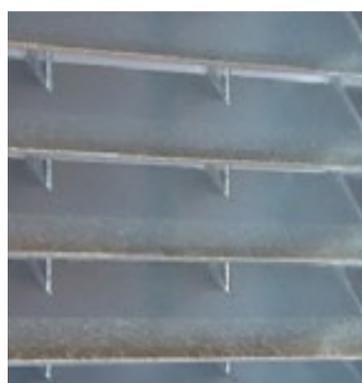
Por norma general, las pletinas, denominadas lamas en este modelo, se colocan inclinadas 45° respecto al plano. Esta característica es muy valorada en casos como salidas de aire de sistemas de ventilación, ya que dificultan en caso de lluvia la entrada de agua en los mecanismos.
