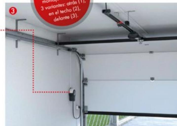
Controlador pro+ con posibilidad de montaje flexible en 3 variantes: atrás (1), en el techo (2), delante (3).
